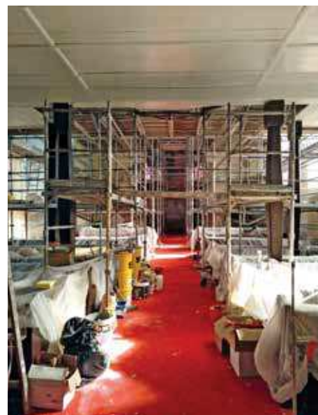
Travaux à l'église de Niederroedern.
